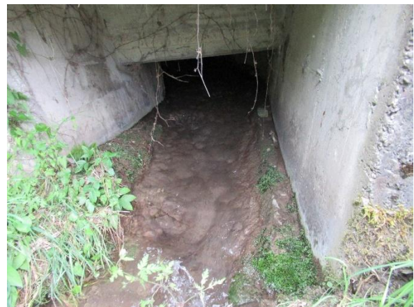
Abb. 2: Auslauf unter Bahngleis
