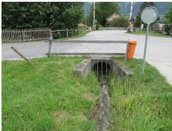
Abb. 1: Bergseitige Ansicht mit Einlaufrost
