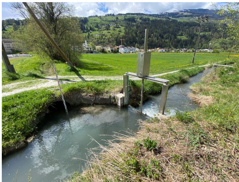
Abbildung 10: Regelungsbauwerk im Abzugskanal direkt nach dem Zufluss des Kettbachs (Rohr) (Foto: HOLINGER AG, 2024)
