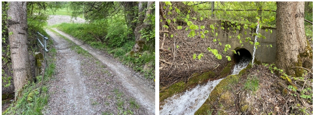
Abbildung 22: Links: Blick nach oben auf der Waldstrasse; Rechts: Auslauf Rohrdurchlass
