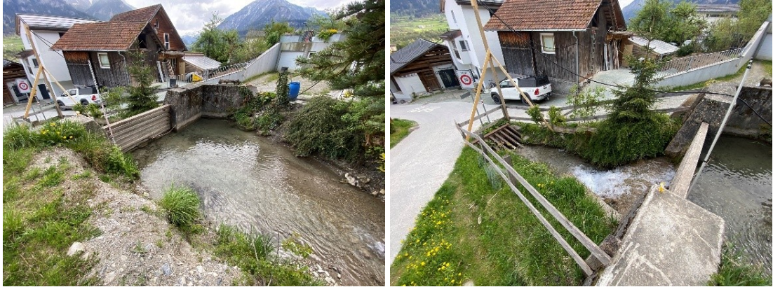
Abbildung 13: Geschiebesammler inklusive Schwemmholzrechen am Kegelhals (Fotos: HOLINGER AG)
